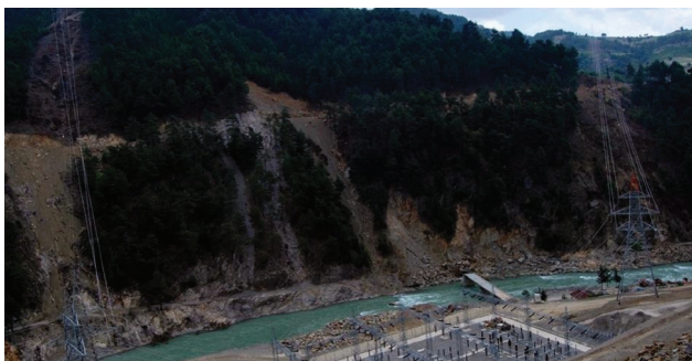
Centrale hydroélectrique d'Uzundere, Turquie Plus d'infos sur la centrale hydroélectrique en Turquie ici .
