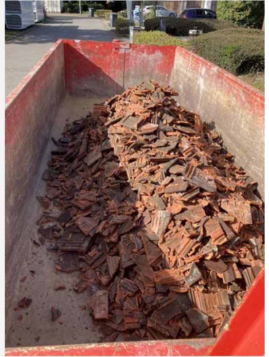
Les tuiles sont collectées dans un conteneur.
