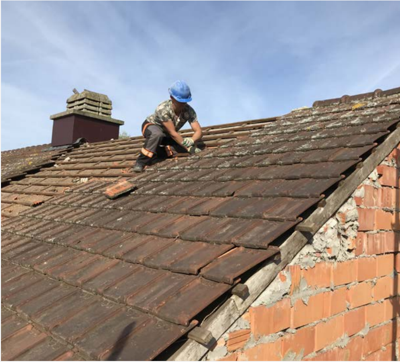
Les tuiles en terre cuite sont retirées du toit.
