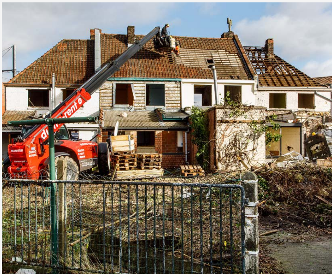
Récupération des tuiles en terre cuite lors du projet Tuighuisstraat © Wonen Regio Kortrijk et Maker & TETRA architecten
