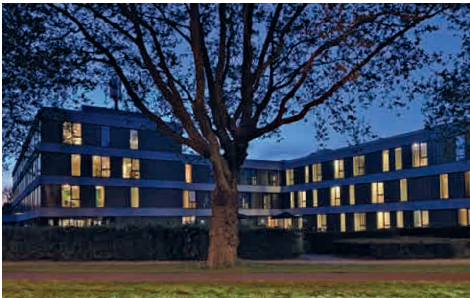
► Campus de soins De State Hillegersberg - Rotterdam (NL)
