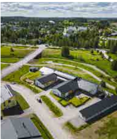
► Maison de repos et de soins - Sipoo (FI)
