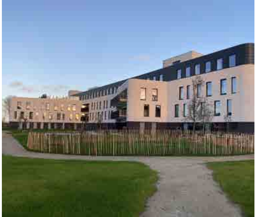
► Maison de repos et de soins Neo - Rocourt (BE)
