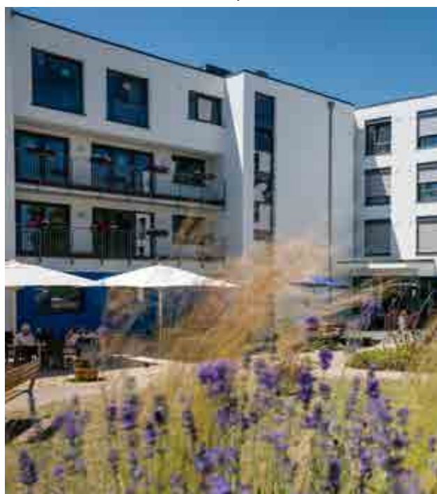
► Maison de repos et de soins – Weilerwist (DE)
